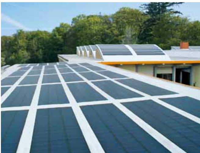
Dachabdichtung mit PV-Modulen auf unterschiedlich geneigten Flächen.
