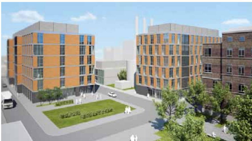
Das Material Research Center (MRC), das derzeit in Darmstadt entsteht, besteht aus zwei Labor- und einem Technikgebäude
