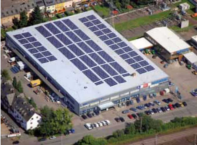
Multifunktionale Kunststoffbahnenabdichtung mit integrierten Photovoltaik-Modulen.
