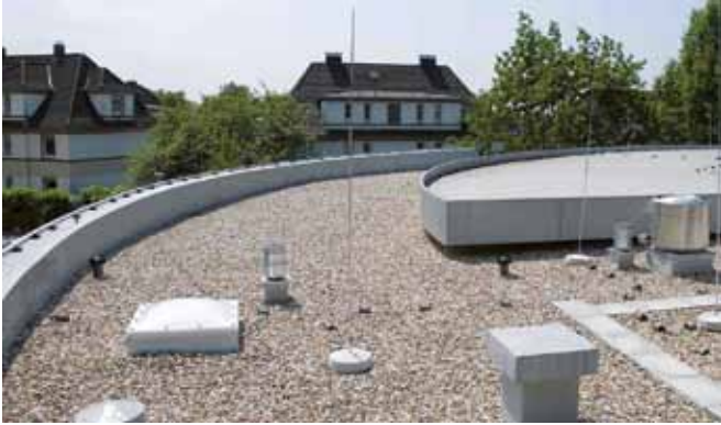
Anschlussdetails fachgerecht geplant und ausgeführt.
