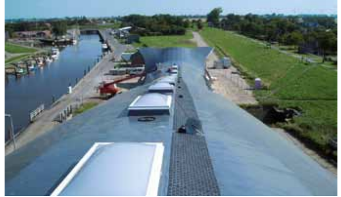
Schnittstellenproblematik bestens gelöst, auch auf ungewöhnlicher Dachkonstruktion.
