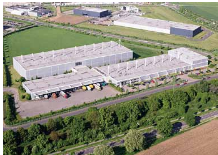
Die Logistik-Anlage der Wenko GmbH & Co. KG spart Betriebskosten durch Volumenoptimierung
