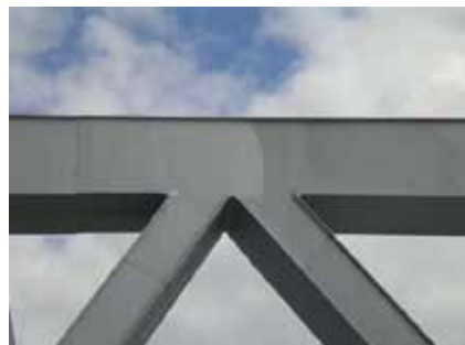
Deckbeschichtung in weißaluminium RAL 9006: Partielle Überarbeitung nach einigen Monaten Freibewitterung. © GEHOLIT + WIEMER
