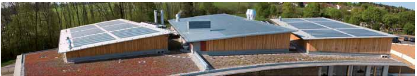
Kombiniertes „Ökosystem“ durch Photovoltaik und Dachbegrünung auf einem Gebäude.
