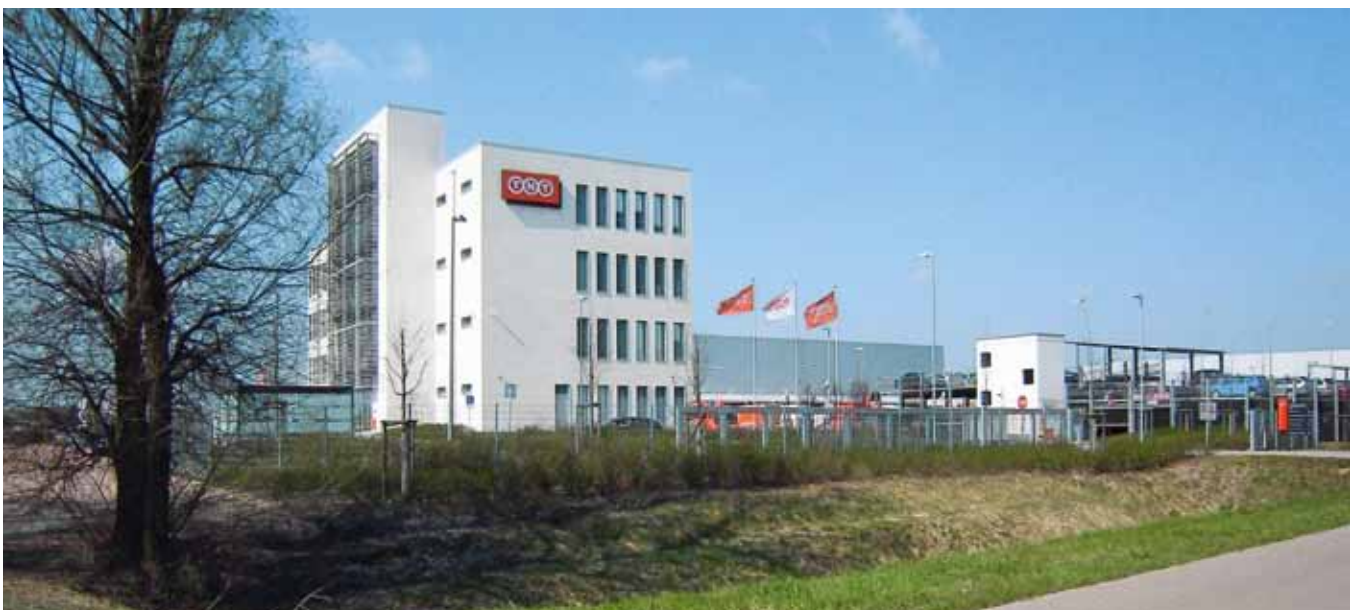
Am Anfang jeder Standortsuche für ein neues Hub oder Depot steht eine detaillierte Bewertung der Ist-Situation
