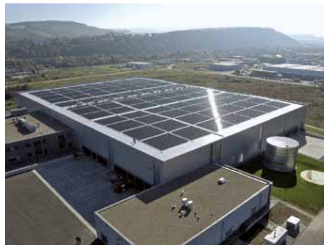
Innovatives PV-System auf weißer, hochreflektierender Kunststoffdachbahn.
