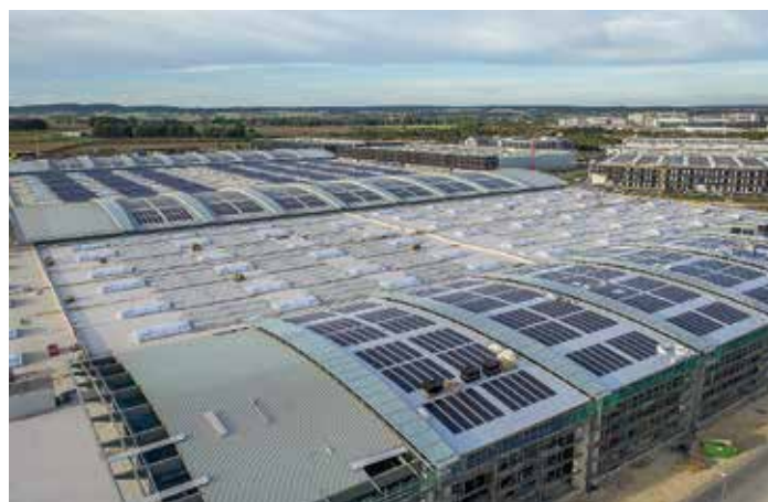
Mit modernen und hochwertigen Kunststoff-Dachbahnen sind gerade auf Industriedachflächen multifunktionale Nutzungen möglich. Die Grundvoraussetzung ist eine fachgerechte Verarbeitung und hohe Lebensdauer der Abdichtungsprodukte.
