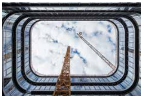
Die leicht schräg gestellten Fassaden der sechs Innenhöfe garantieren viel Tageslicht im Inneren.
