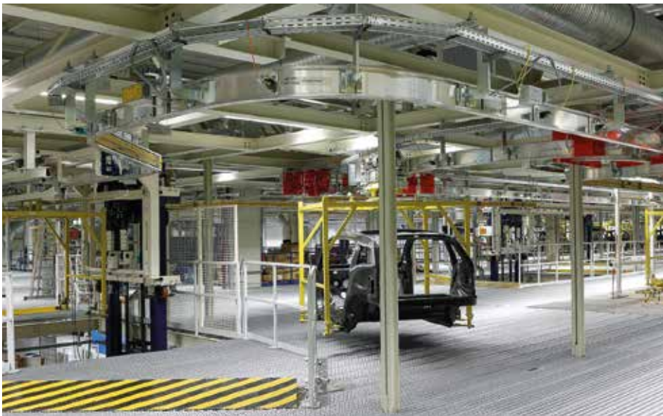
oben links: BMW-Werk Leipzig: Im Gebäude für die i3 Produktion werden die Karosserien aus carbon- faserverstärktem Kunststoff (CFK) hergestellt.
