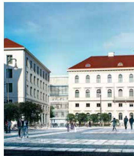
Rendering Wittelsbacherplatz: Das denkmalgeschützte Palais Ludwig Ferdinand erhielt eine Kernsanierung und integriert sich in den Neubau. Eine Brücke verbindet die Baukörper.
