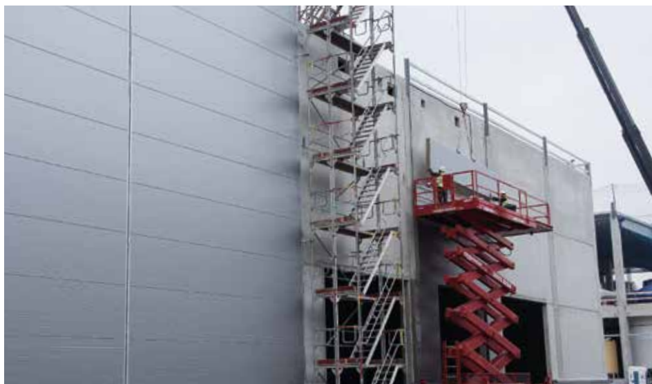
Die großformatigen Elemente erlauben hohe Spannweiten, was Montage- und damit Bauzeiten verkürzt.
