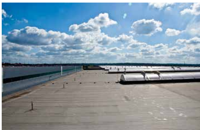
Bei der Abdichtung von Industriegebäuden spielen dauerhafte Funktionssicherheit und geringe Brandlast eine große Rolle.
