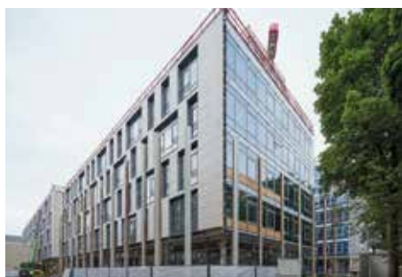
Helle Natursteinfassaden referenzieren im Bereich der Seitenstraßen auf die umgebende Bebauung.
