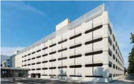
Das BMW Parkhaus selbst wurde mit neuem Stahlverbundtragwerk hinter der Fassade komplett neu errichtet.
