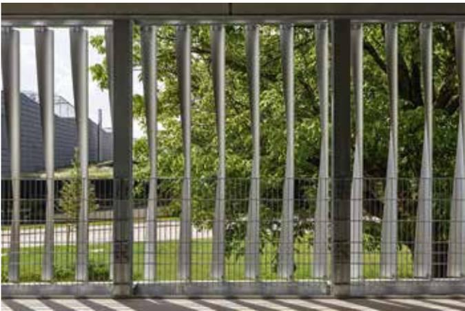
Fassade mit Ausdruck unternehmenseigener Kompetenz – die vertikal gerichteten Finnen wurden auf Trumppf-Maschinen aus einem Metallrohr herausgeschnitten.
