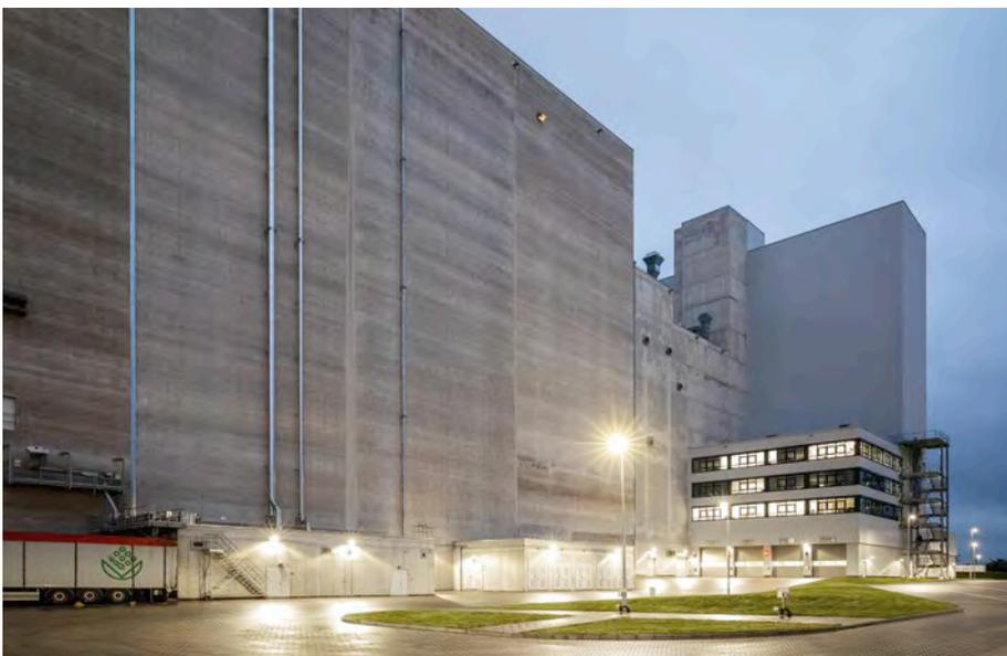
Dank Gleitbauweise entstand eine homogene Betonfassade mit „textiler Ästhetik“.
