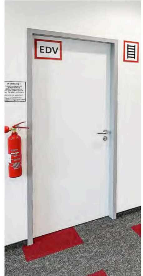
Räume für die Elektrounterverteilung mussten brandschutztechnisch komplett gekapselt werden. Sie erhielten selbstschließende t30rs-Türen. Feuerlöscher für den Einsatz bei Elektrobränden sind griffbereit.
