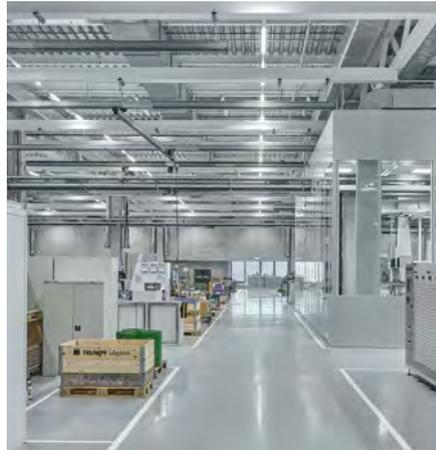
Besonderheiten im Tragwerk sind die in der Binderebene geführten Installationen und Leitungen.
