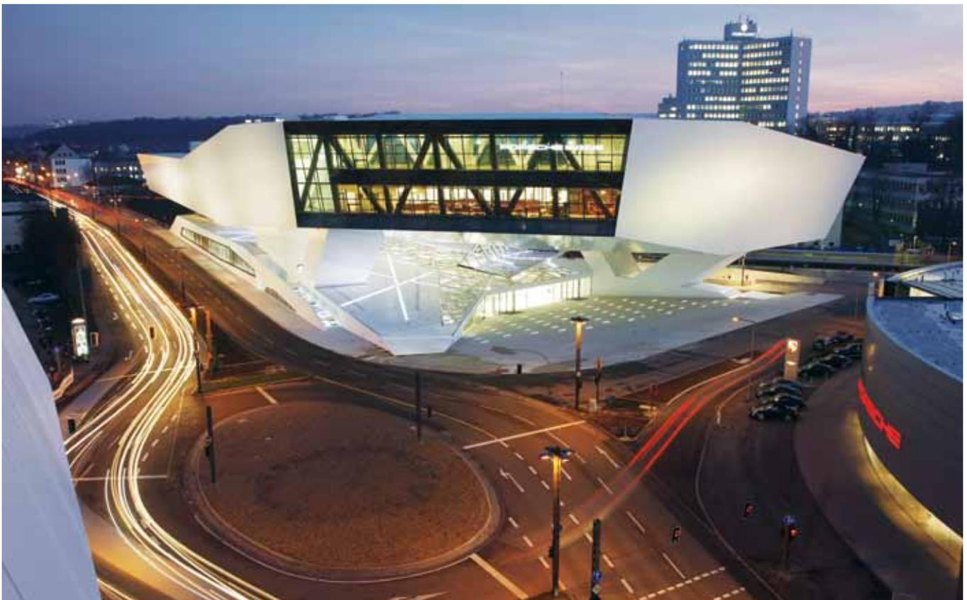
Zwei Baukörper, Basement und Ausstellungsbereich, bestimmen die Geometrie des Museums. Die 160 Meter lange räumliche Stahlkonstruktion des Ausstellungsbereichs schwebt über der Basis
