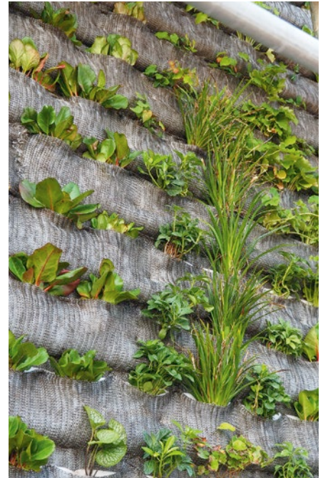
Die Pflanzen wachsen in einem Behältnis aus nichtbrennbarem Spezialvlies, das mit Substrat gefüllt und direkt an der Fassade angebracht ist.
