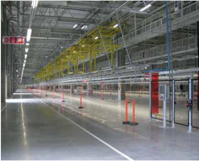
Das Innere der Montagehalle.
