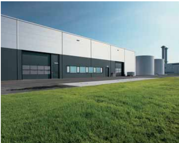
Das Gebäude strahlt eine besondere Industrieästhetik aus.
